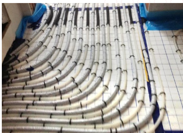
bavaria-DLZ-Dämmung auf Flies-Tackersystem
