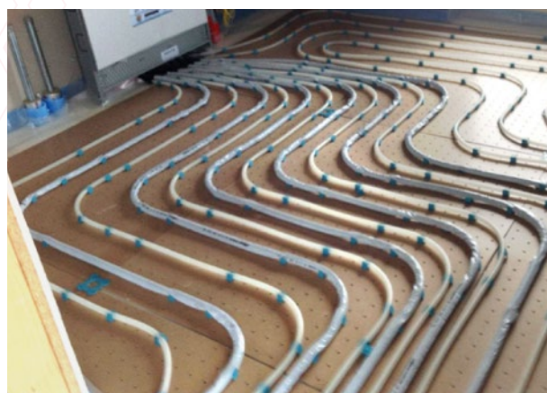
bavaria-DLZ-Dämmung auf bavaria-Biofaser-Lochplatte
